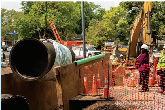
Los equipos de construcción de la PWSA instalan un segmento de la Tubería de impulsión 4, una gran tubería de distribución de agua, en las cercanías de Highland Park.
